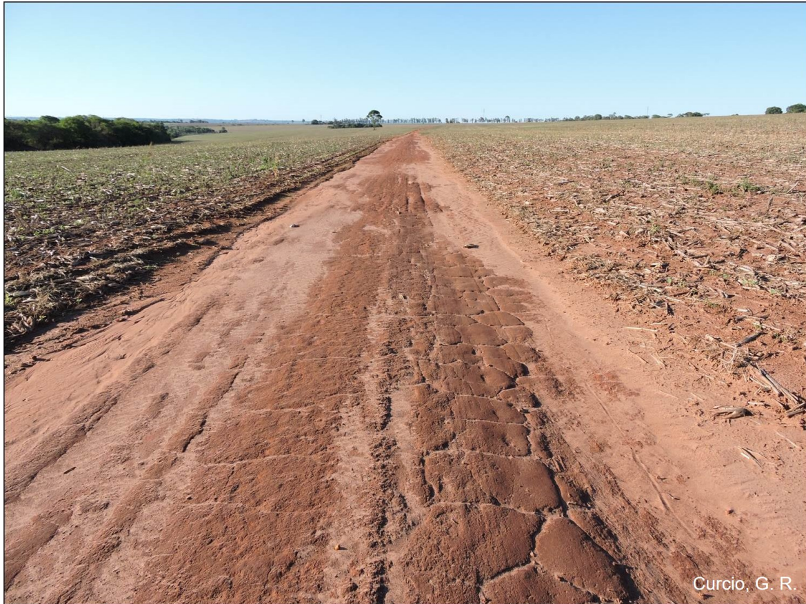
Figura 4 - Estrada em Latossolo Vermelho textura média.
