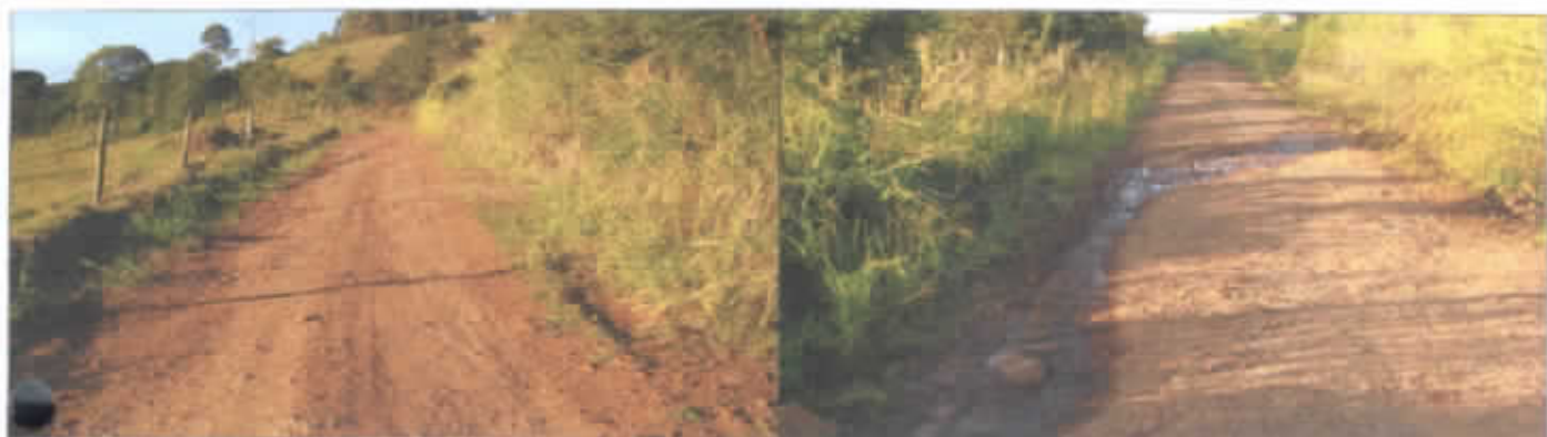
KM 8 TRECHO DA ESTRADA MUNICIPAL N. 01
