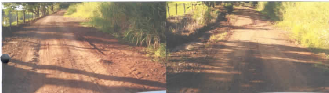
KM 03 DA ESTRADA MUNICIPAL N. 01
