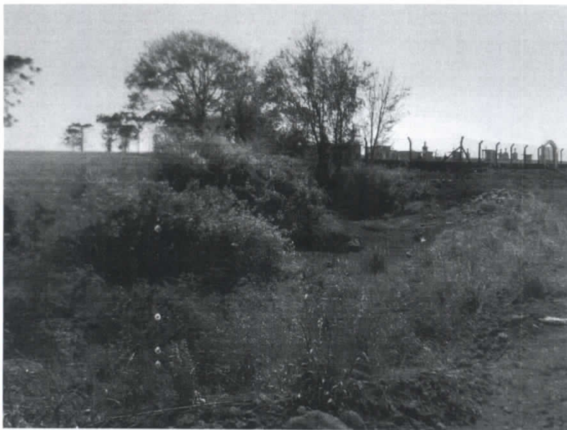
Imagem 08: Presença de valeta ao lado da estrada.
