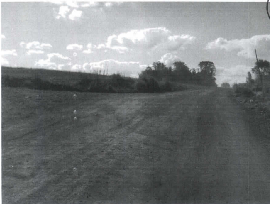
Imagem 03: Início do trecho a ser pavimentado – Trecho 01.
