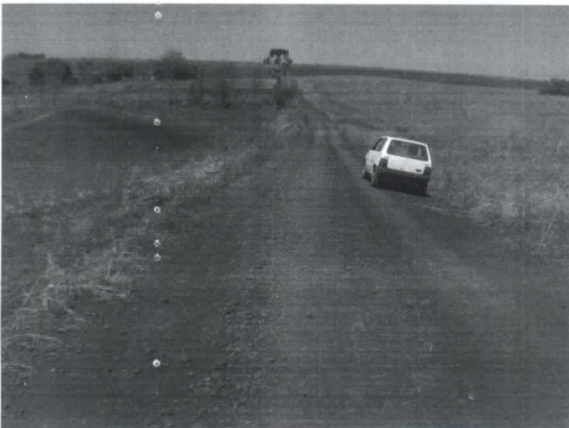
Imagem 06: Término do trecho a ser pavimentado – Trecho 04.
