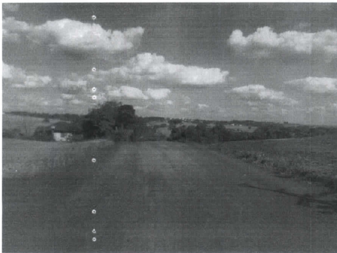
Imagem 06: Término do trecho a ser pavimentado – Trecho 01.
