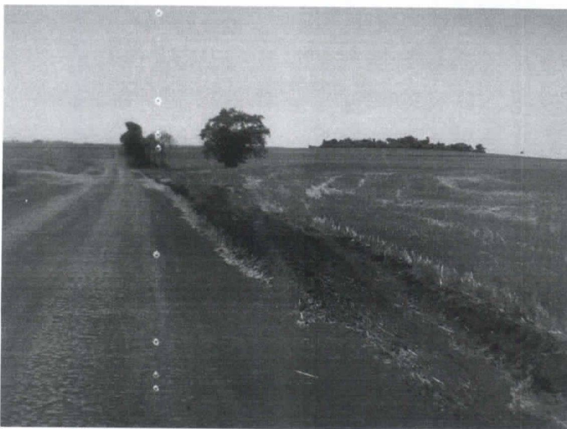
Imagem 09: Término do trecho a ser pavimentado – Trecho 3.
