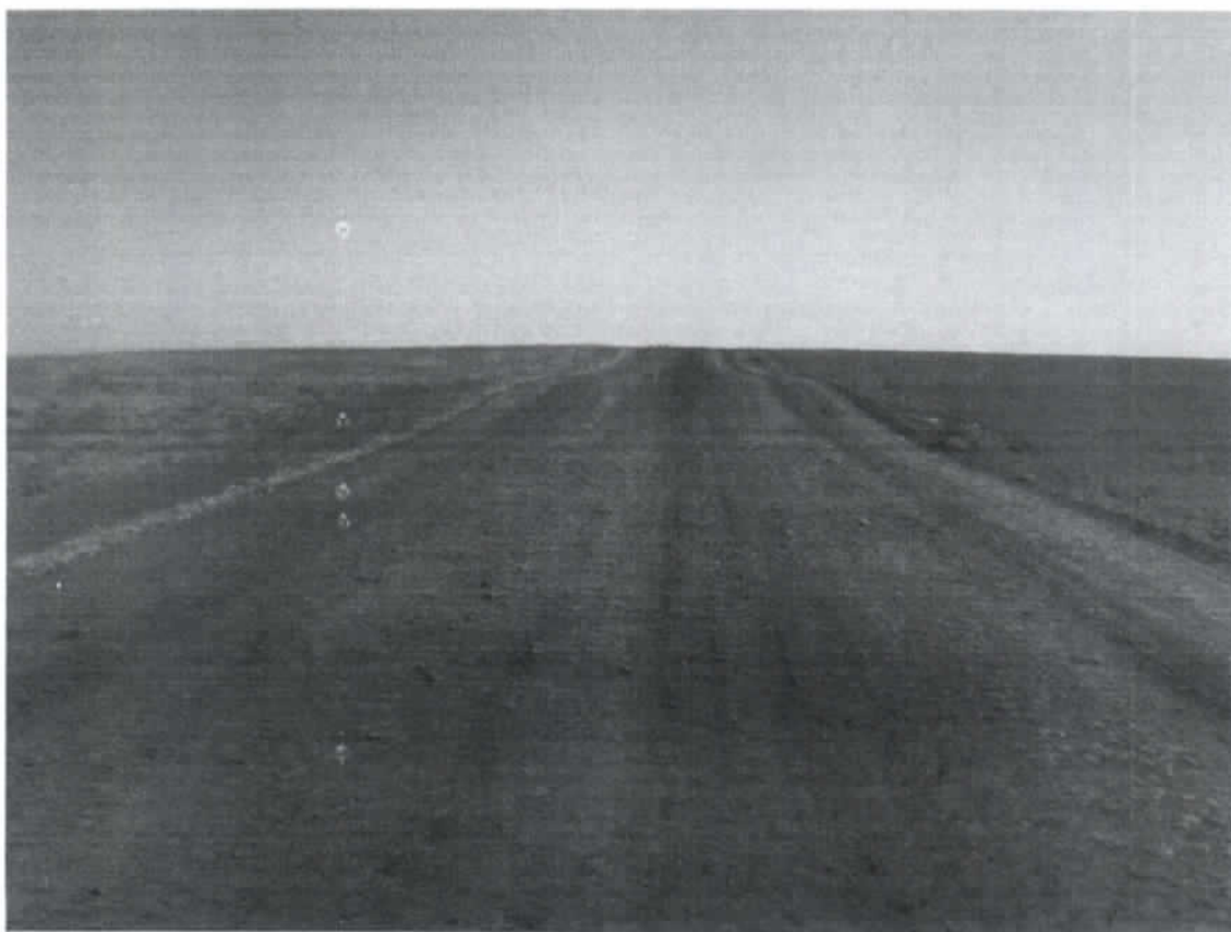
Imagem 06: Início do trecho a ser pavimentado – Trecho 03.
