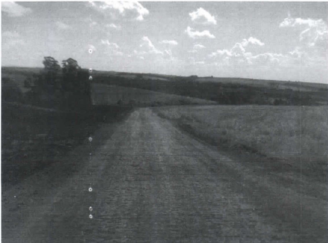
Imagem 06: Término do trecho a ser pavimentado – Trecho 02.
