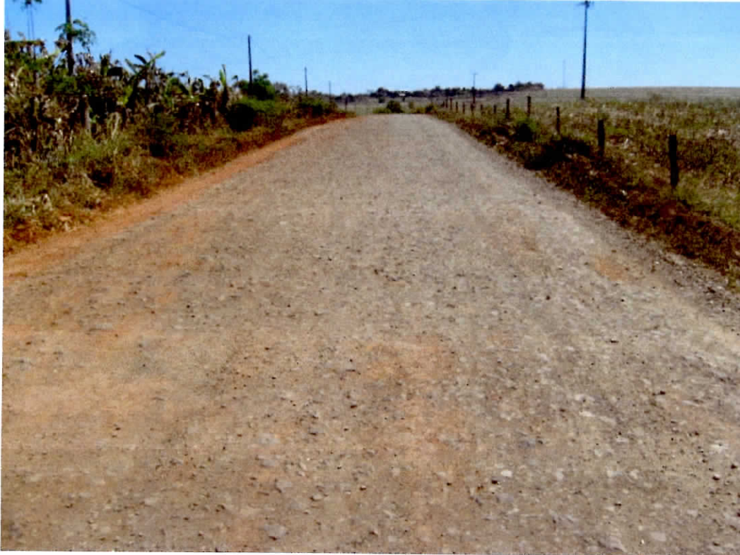
Foto 13 – Final do Trecho (ponto Final)
