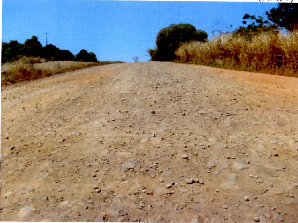
Foto 8 – Detalhe do moledo existente e abaulamento da estrada (ponto 7)
