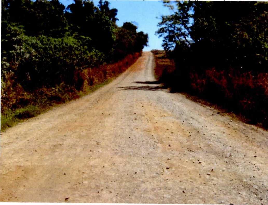
Foto 8 – Detalhe do moledo existente e abaulamento da estrada (ponto 7)
