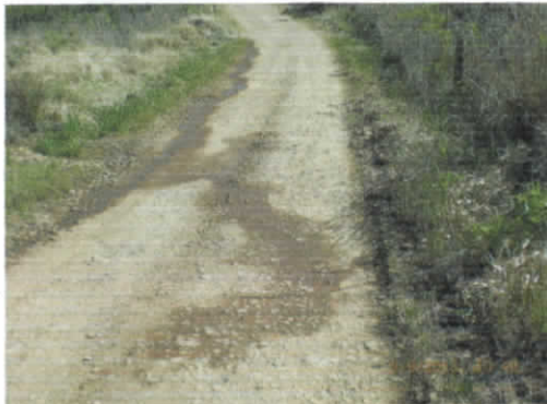
Foto 1: Mostra trechos onde haverá drenagem lateral, sangradouros.
