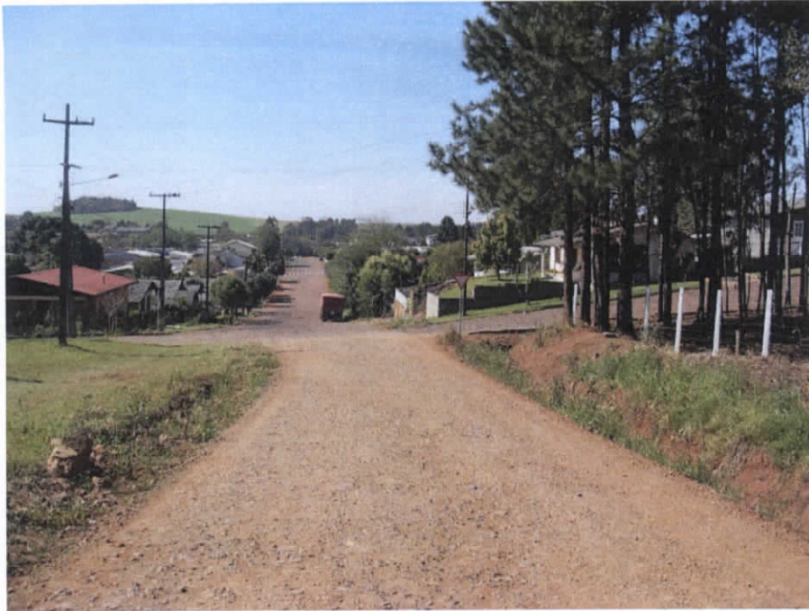
Figura 2. Ponto inicial do trecho
