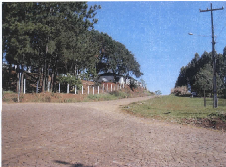
Figura 1. Ponto inicial do trecho
